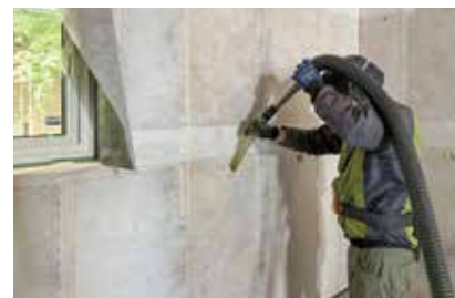
「シュタイコ」を壁内に注入する様子。壁内の隅々まで隙間なく詰め込むことで高い性能を発揮します
