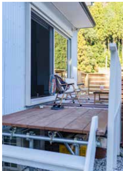
窓とスケートランプをつなぐ位置にあるウッドデッキは、単管パイプと木材を組み合わせで DIY した
